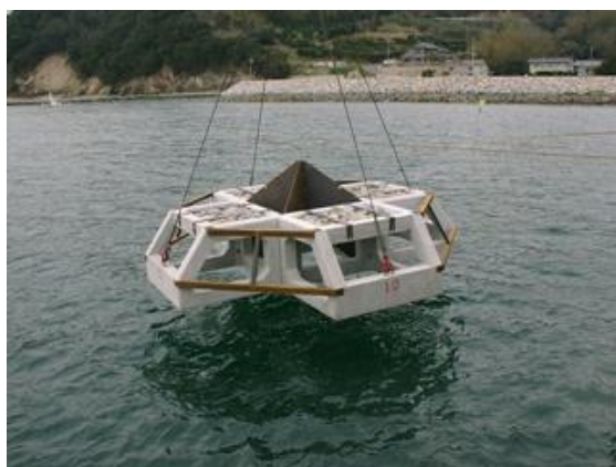
コンクリート構造物の藻礁 「シーマークリーフ」
