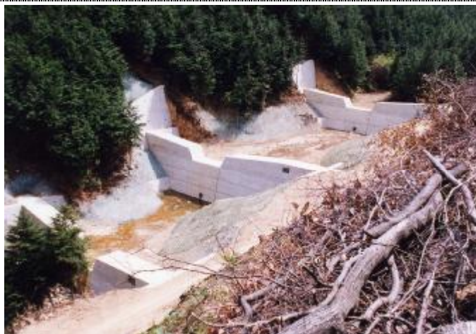
(写真は治山ダム)
