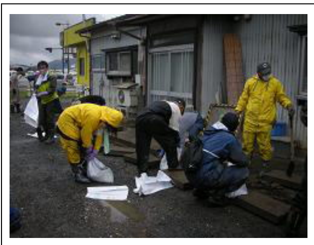
側溝の泥出し
