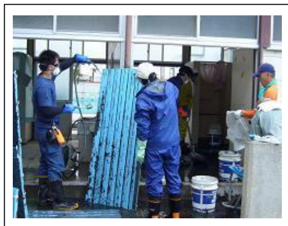
プール更衣室の泥出し
