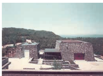
完成した漁撈収蔵庫（昭和55年）
