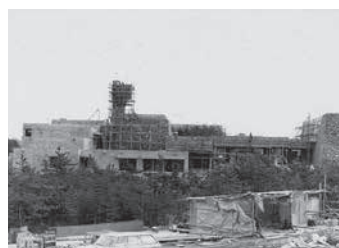
建設中の当館（昭和47年頃）
