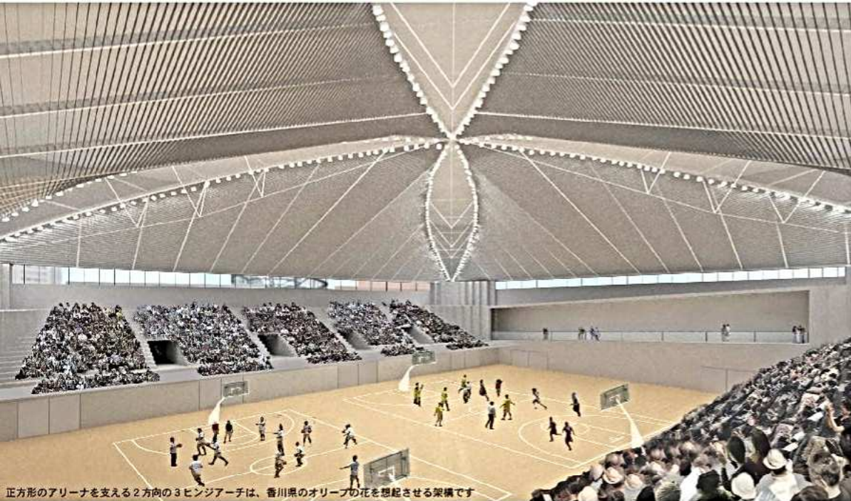
正方形のアリーナを支える2方向の3ヒンジアーチは、香川県のオリーブの花を想起させる架構です
