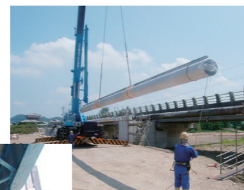
水道管の更新・耐震化工事
