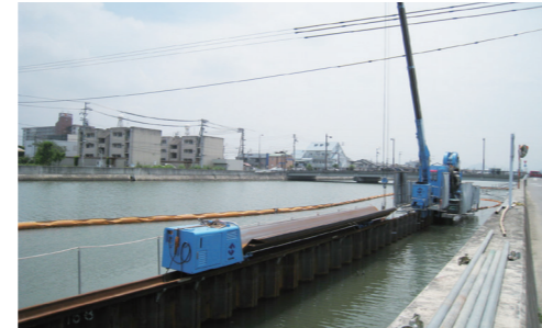
地震・津波対策工事
