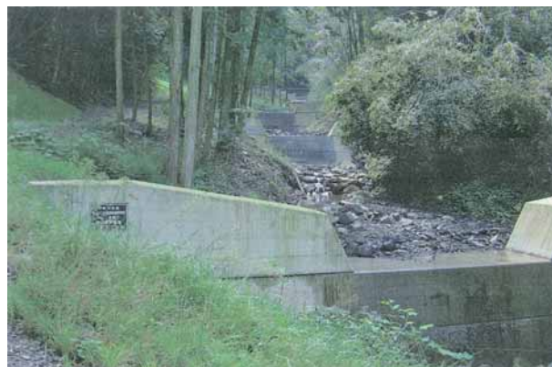
治山事業を実施していた箇所（三豊市）
