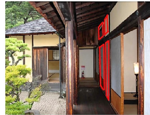
掬月 南縁側 三の間 9通り 構造用合板
