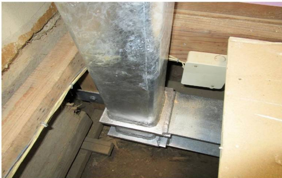
片持鉄骨柱を鉄骨土台で受ける
