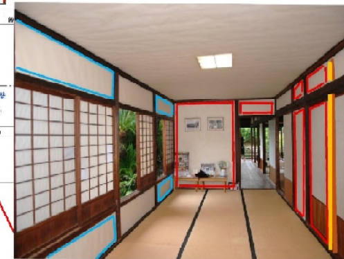
北入側の間 と、11通り 構造用合板 か、13通り 斜め木摺壁
