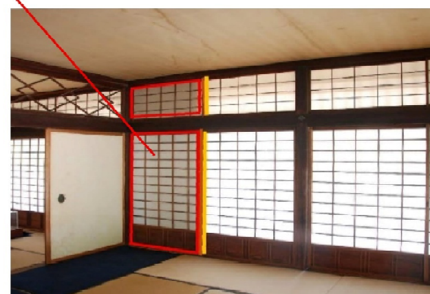
初莚観北棟 北の間 け通り 構造用合板
