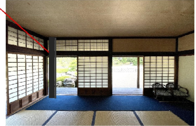
初莚観北棟 北の間 鉄骨柱 12
