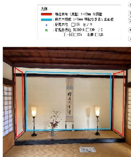
一の間 9、11通り 構造用合板 リ通り 斜め木摺壁
