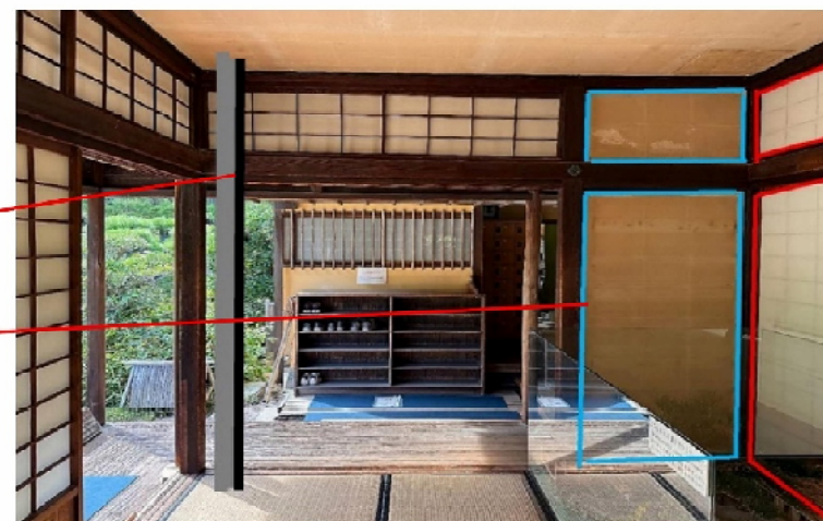
初筵観 南入側の間 鉄骨柱 4、斜め木摺壁
