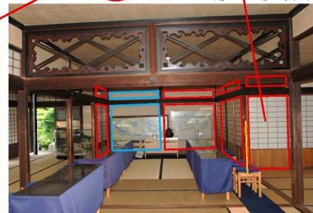
二の間・北入側の間-2 構造用合板、斜め木摺壁
