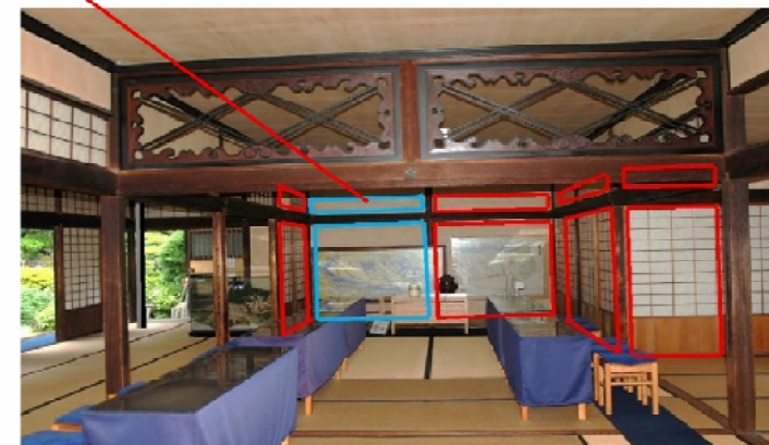
二の間・北入側の間-2 構造用合板、斜め木摺壁
