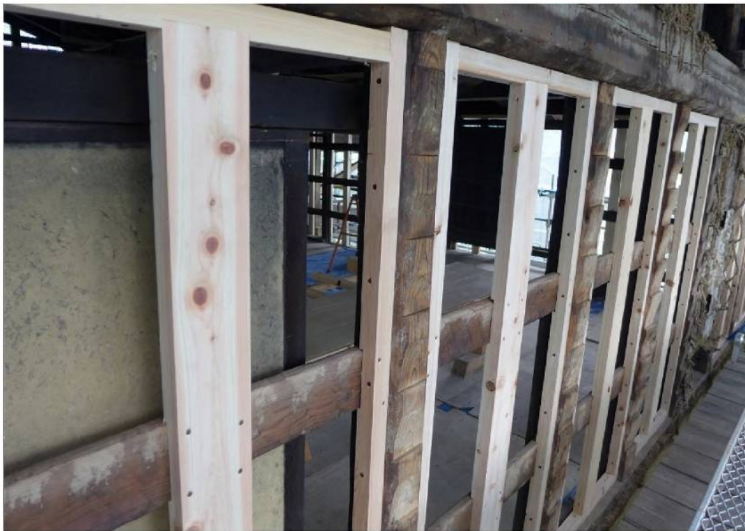
耐力壁構造用合板受け材設置
