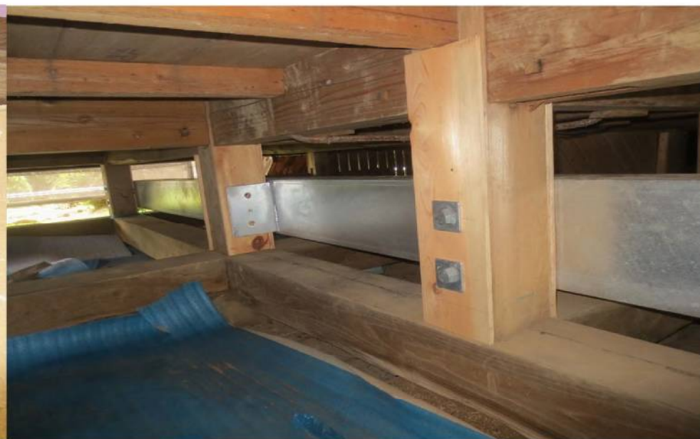
鉄骨基礎梁が既存柱の柱脚に固定し、建物自重を反力とする
