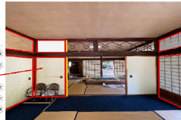
初莚観北棟 北の間 23 通り 構造用合板
