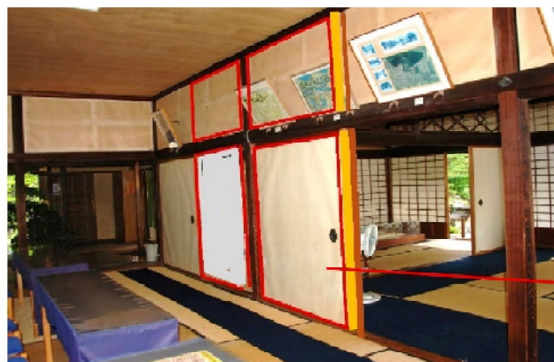
初莚観北棟 中の間 お通り 構造用合板
