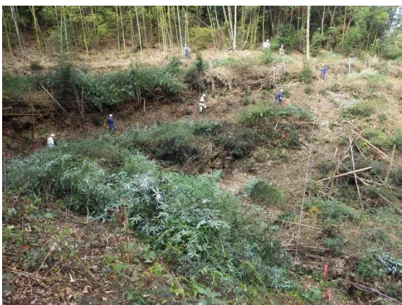
<急な斜面での作業です>
