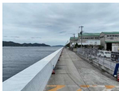
対策工事状況（対策後）
