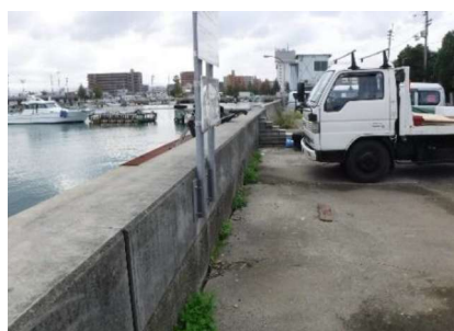
対策工事状況（対策前）
