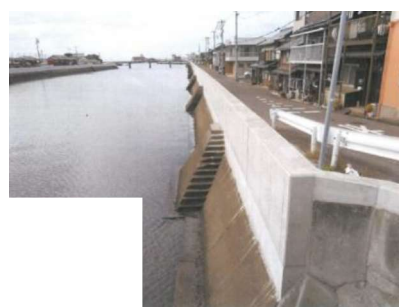
対策工事状況（対策後）
