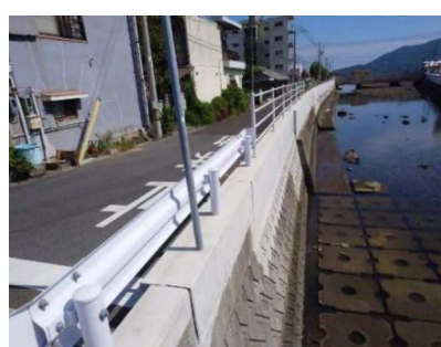
対策工事状況（対策後）
