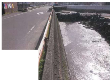
対策工事状況（対策前）
