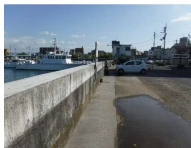
対策工事状況（対策後）
