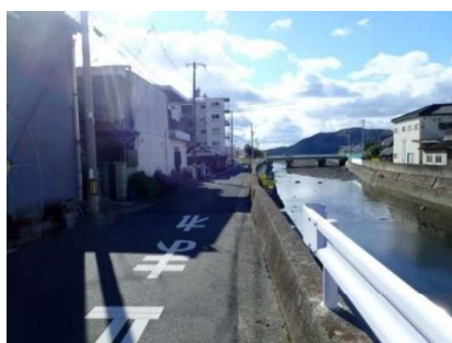
対策工事状況（対策前）
