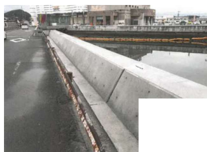
対策工事状況（対策後）
