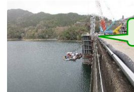
工事中を見学
