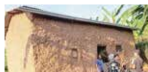
ルワンダでの一般的な家(土壁・トタン屋根・床はなく地面に布を敷く)
