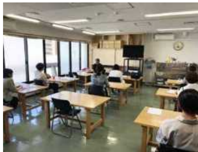
7階にある絵画室は、曇りの日や雨の日など雲で太陽光が散乱される日でも、室内を一定の明るさに保つように蛍光灯を配置しています。
