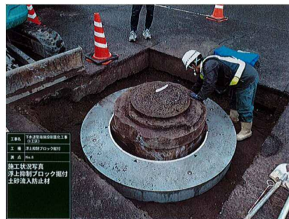
下水道管路施設耐震化工事(1工区)
