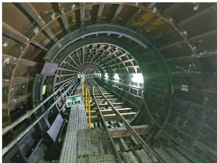
西部バイパス幹線内部(施工中)
