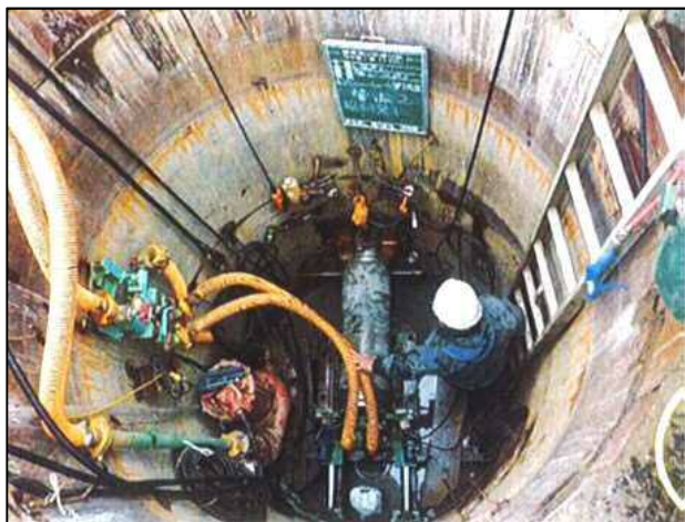
汚水管渠布設工事【推進工法】(高松市)
