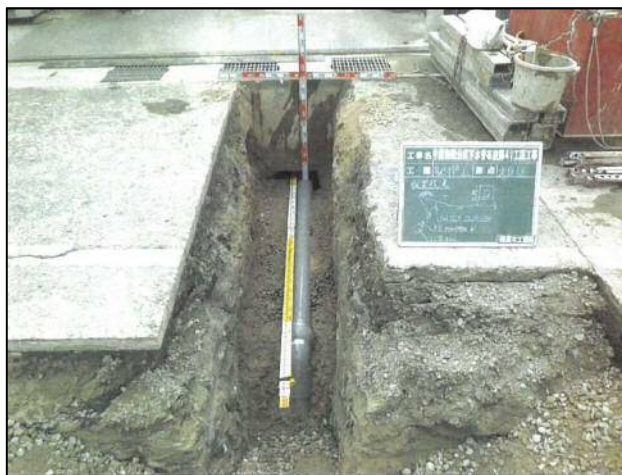
汚水管渠布設工事【開削工法】(丸亀市)
