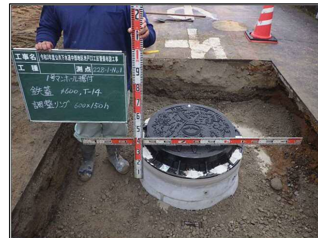
人孔設置工事(三木町)
