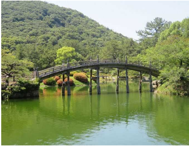
【整備前】木製橋梁の腐食・破損
