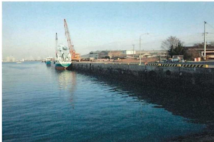
岸壁全体状況
