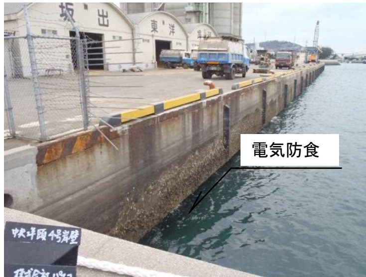
現地状況写真
