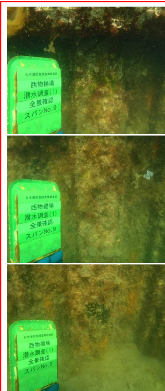
鋼矢板現況写真(潜水調査時)
