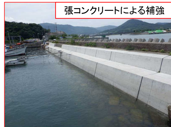
香西西防波堤(整備後)
