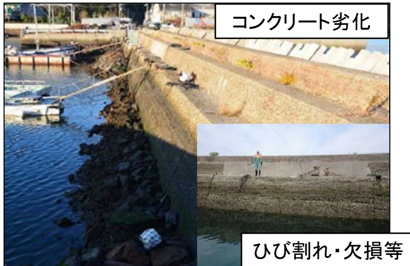
香西西防波堤(整備前)
