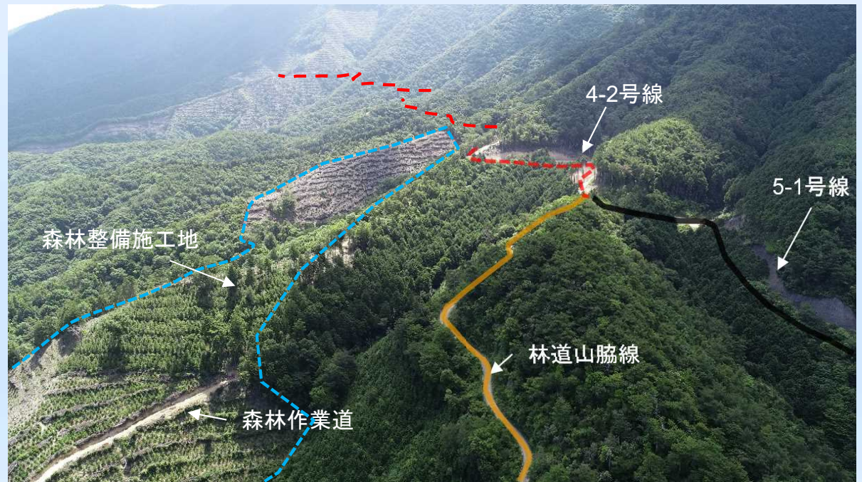
写真③ 琴南財田線と既設林道、森林作業道との連携
