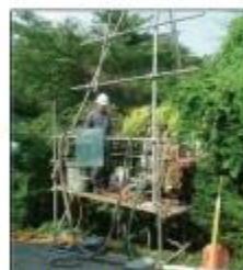
ボーリング調査
