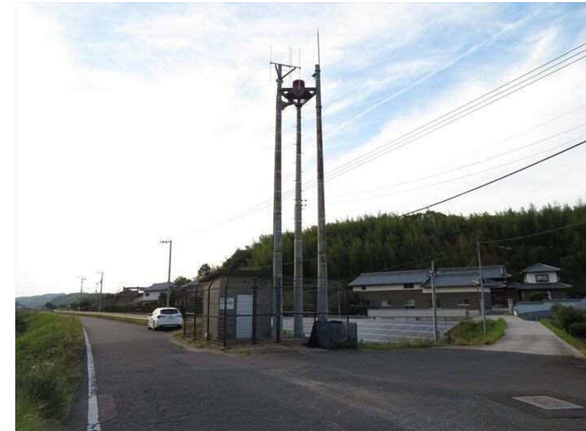
放流警報設備の改良(前山ダム(さぬき市)乙井警報局)
