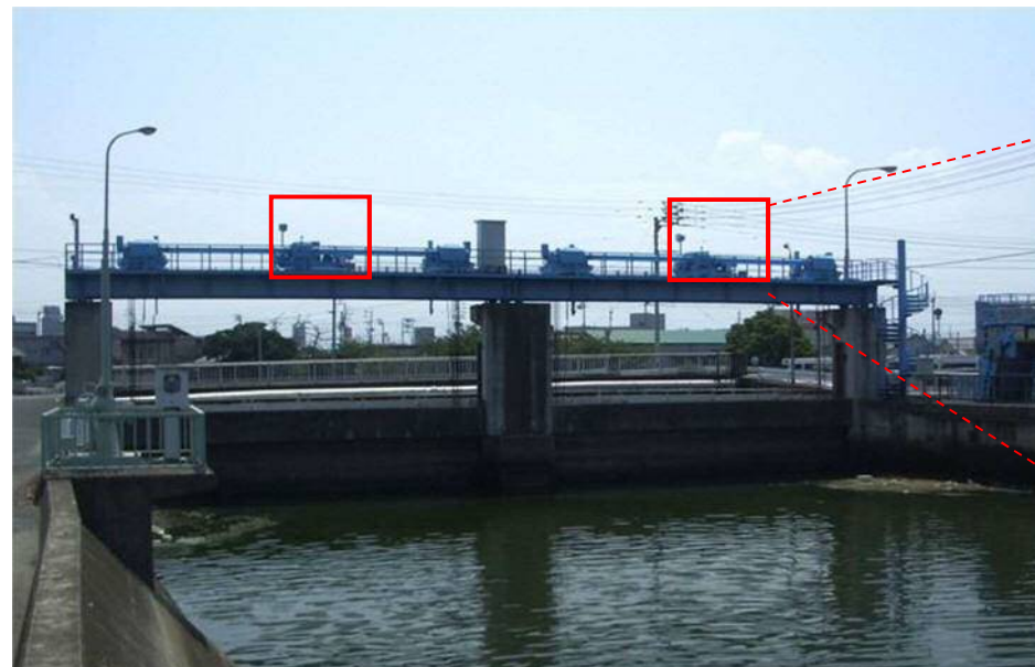
一の谷川(七間橋防潮水門)
