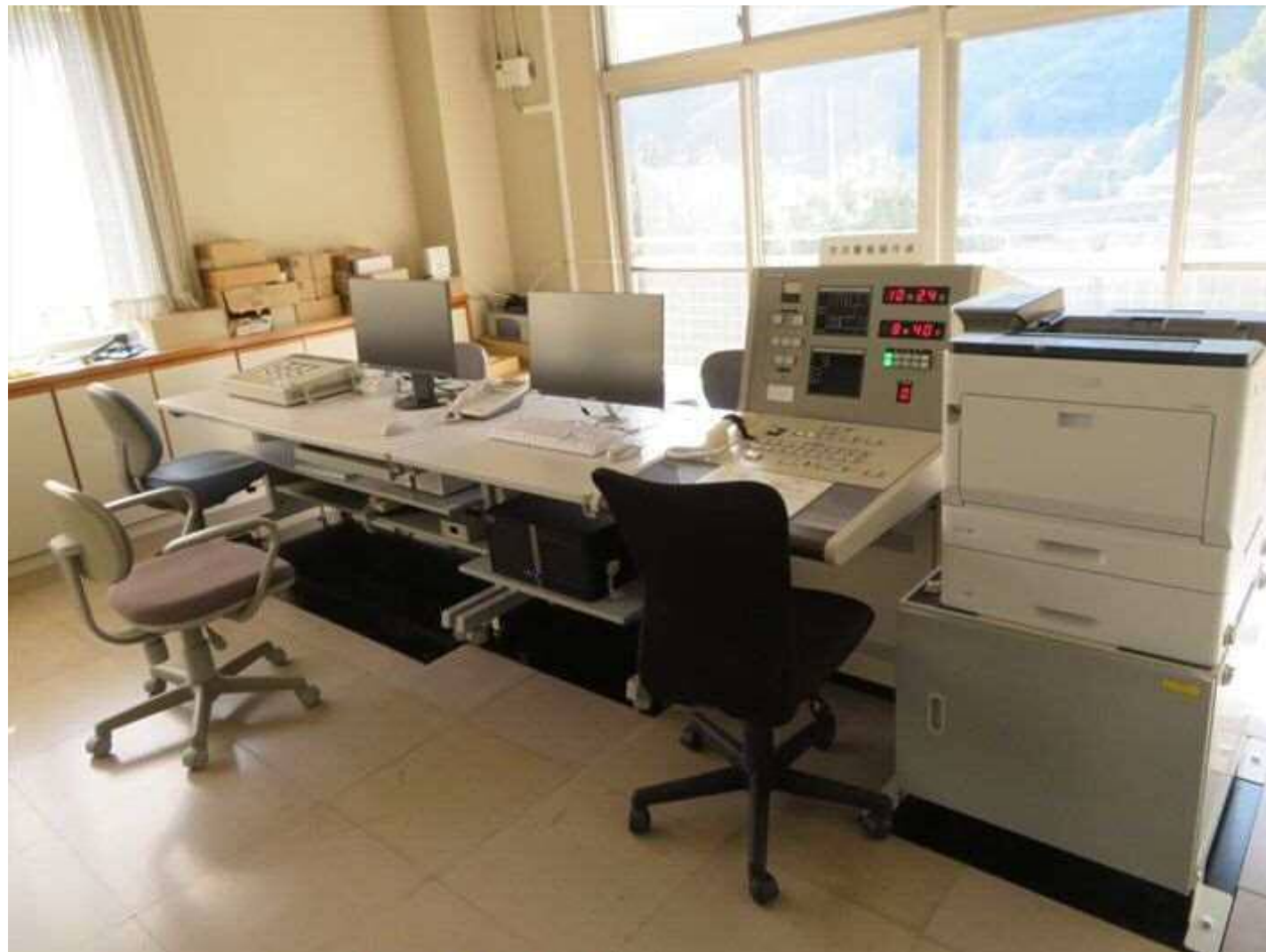
ダム管理用制御処理設備の改良 (千足ダム(東かがわ市))
