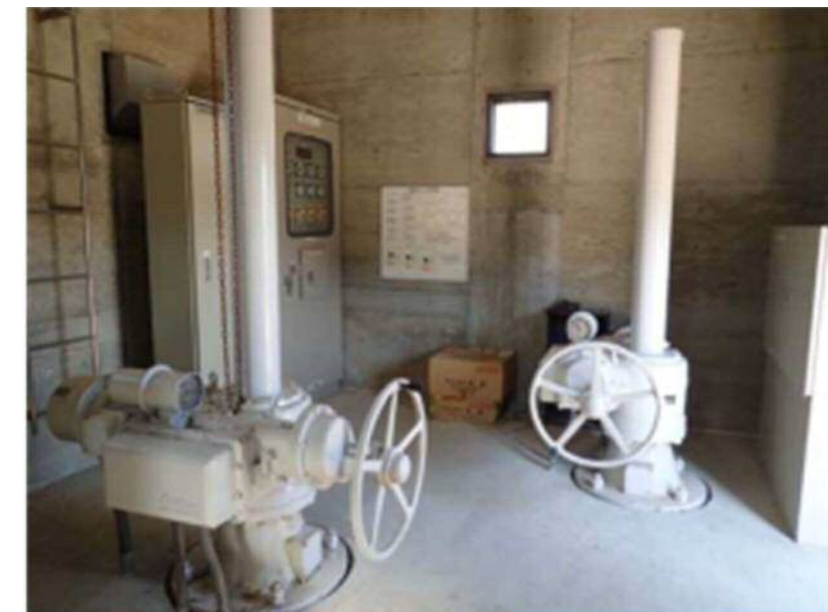
放流設備の改良など(吉田ダム(小豆島町))
