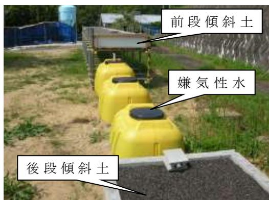
図 1 傾斜土槽法による水質浄化装置
