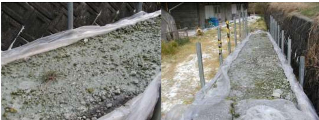
図12 傾斜土槽内部の目詰まりにより表面流下がおきている状態。(2007年3月)
