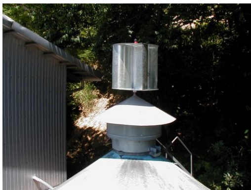
図1 サボニウス型小型風車を設置した「かざぐるま式換気蓋」
