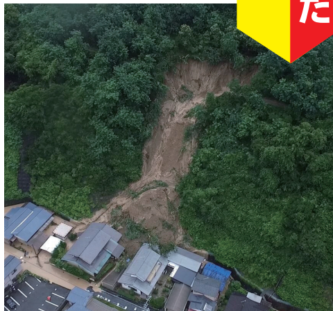
西日本豪雨による災害(高松市)
