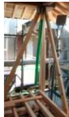
筋交いを設置し耐震性を強化
