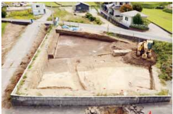
写真 9 調査区全景 (西から)
