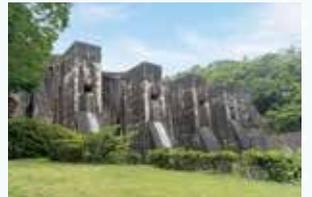
豊稔池に隣接し、目の前には堤長145.5m、堤高30.4mの「豊稔池堰堤」がそびえ立ちます。5つのアーチと6つの擁壁を持つ国内唯一の「石積み式マルチプルアーチダム」です。
