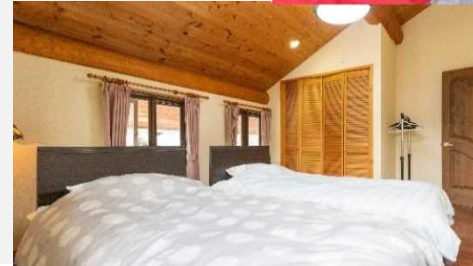
防災カーテン・火災報知器を設置
