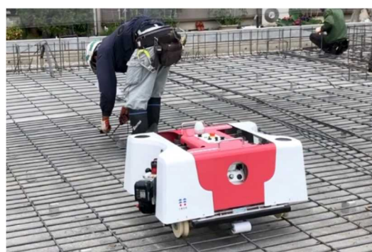
(参考2) 鉄筋結束ロボット「トモロボ」
