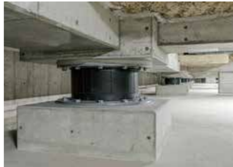
耐震改修を実施した県庁舎東館
