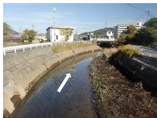
鴨田川 若宮橋下流（河口から約0.1km付近）
