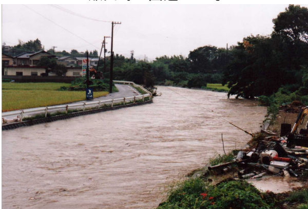
飯山町 東坂元 久保橋 平成 10 年 9 月台風 7 号による出水
