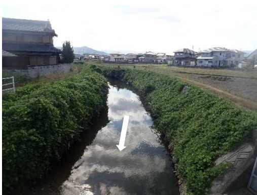
大東川 次郎橋上流（河口から約9.5km付近）
