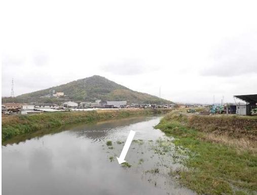
大東川 新大東川橋上流（河口から約1.6km付近）
