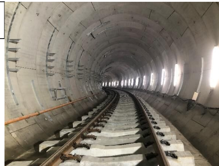
シールド部 (レール設置)
