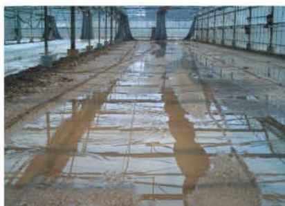
湛水した状態
