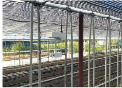
2連棟ハウスの中心部に設置
