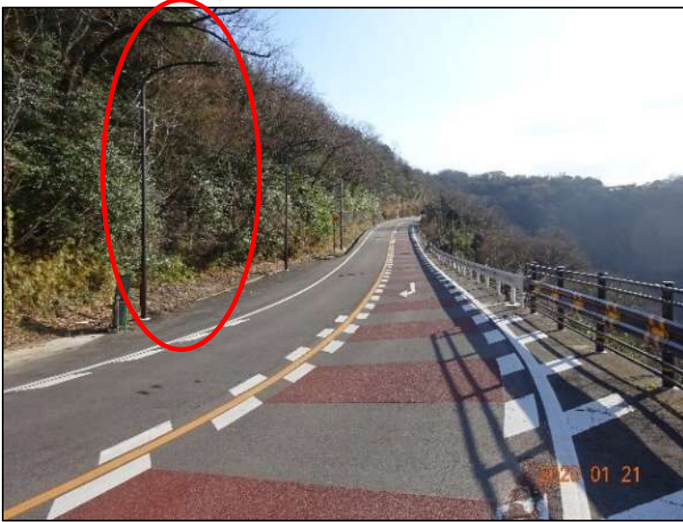
舗装の修繕、道路照明灯の更新
