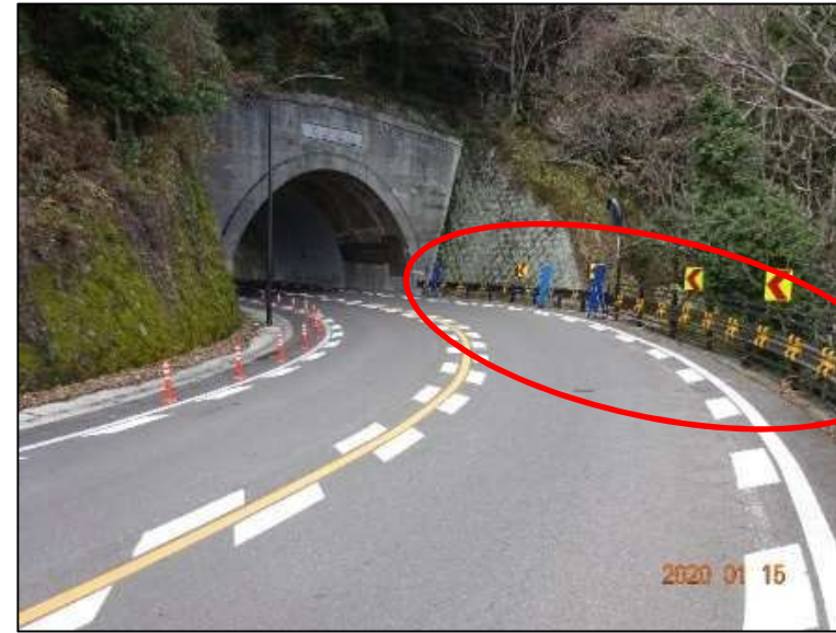
舗装の修繕、ガードレールの更新
