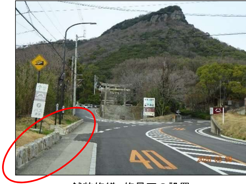
舗装修繕、修景石の設置
