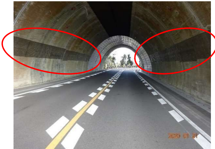
舗装の修繕、トンネル内面の補修
