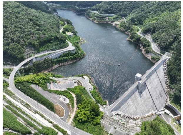
椋川ダム（貯水池全景）
