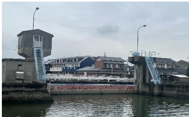
牟礼川防潮水門
