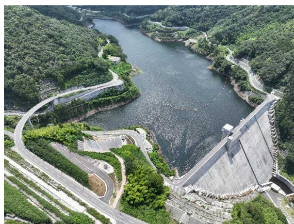
栂川ダム（貯水池全景）
