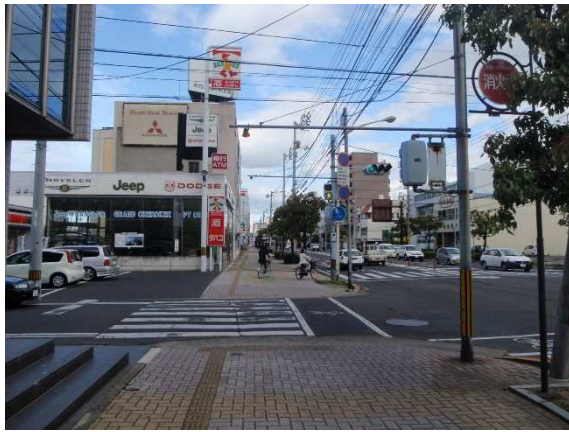
電線共同溝（整備前）
