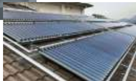
太陽熱集積器設置の様子 写真提供：宮地電機(株)
