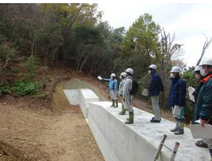
④【見学】治山施設
