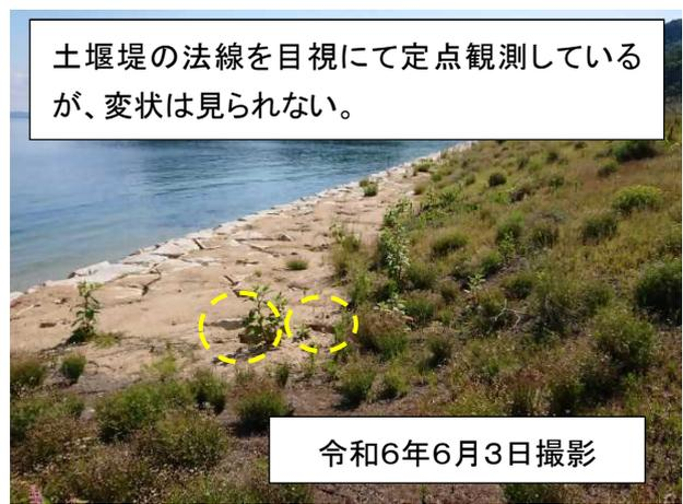
土堰堤の法線を目視にて定点観測しているが、変状は見られない。
