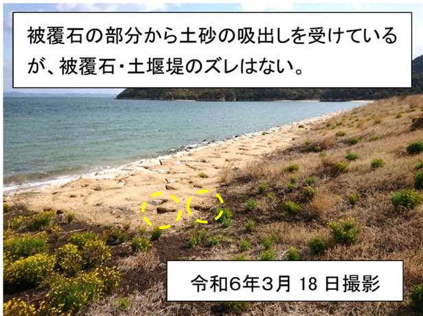
被覆石の部分から土砂の吸出しを受けているが、被覆石・土堰堤のズレはない。
