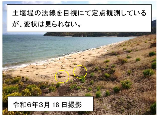
写真6 土堰堤（陥没状況：本堤への影響なし）
