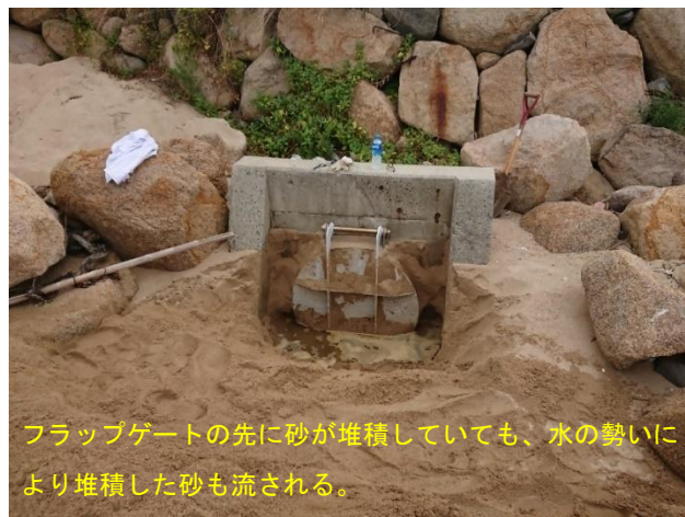
写真8 導水管出口（撤去作業後）
