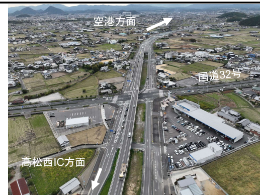
円座香南線(中間工区)の状況
