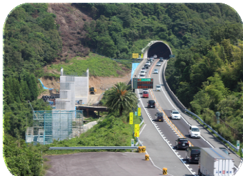
(東かがわ市：四国横断自動車道)
