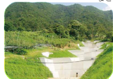
(観音寺市：治山ダム)
