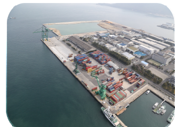
(高松市：高松港コンテナターミナル)
