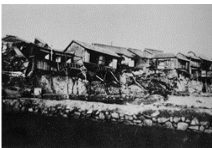
(昭和21年 南海地震による被害) (坂出市)
