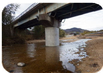
(さぬき市：寺尾橋)
