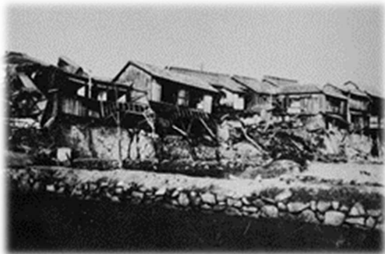
(昭和21年 南海地震による被害)
