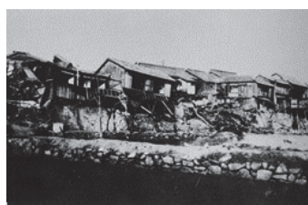
(昭和 21 年 南海地震による被害)
