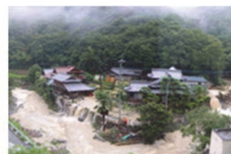
(平成 16 年 台風 15 号と前線による被害)
