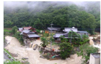
(平成 16 年 台風 15 号と前線による被害)
