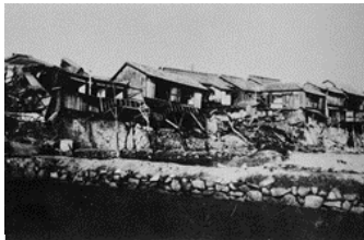
(昭和 21 年 南海地震による被害)
