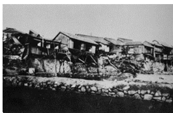
(昭和 21 年 南海地震による被害)
