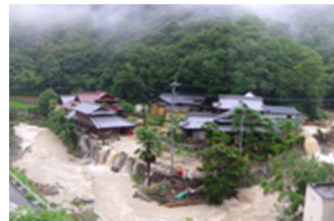
(平成 16 年 台風 15 号と前線による被害)
