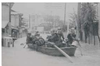
(昭和 51 年 台風 17 号による被害)
