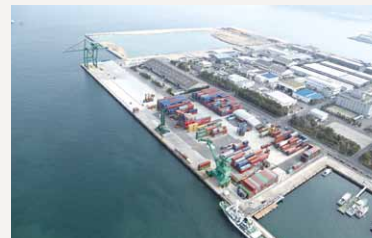
▲高松市：高松港コンテナターミナル
