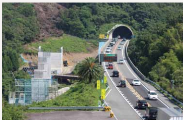
▲東かがわ市：四国横断自動車道
