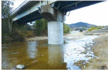
▲さぬき市：寺尾橋
