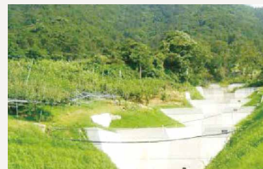
▲観音寺市：治山ダム
