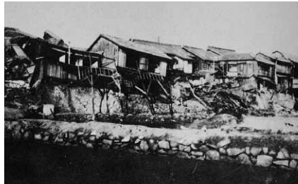
▲昭和21年 南海地震による被害 (坂出市)
